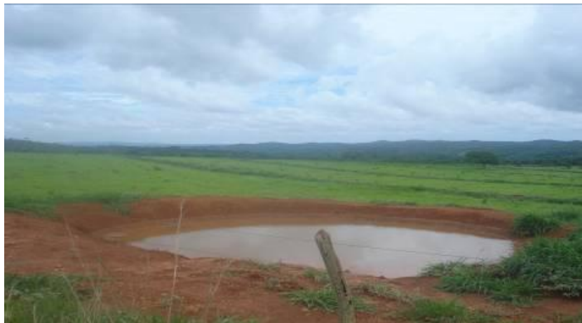
Figura 13: Exemplo de barraginha
