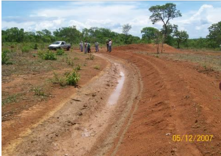
Figura 14: Exemplo de terraço executado
